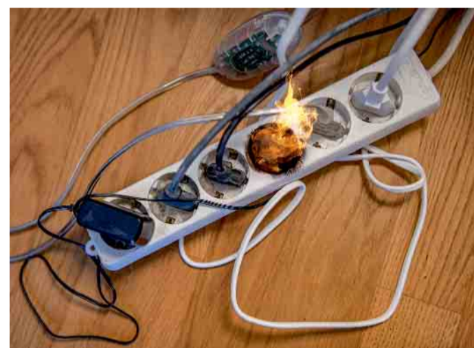
Brennende Steckerleiste durch Kurzschluss
