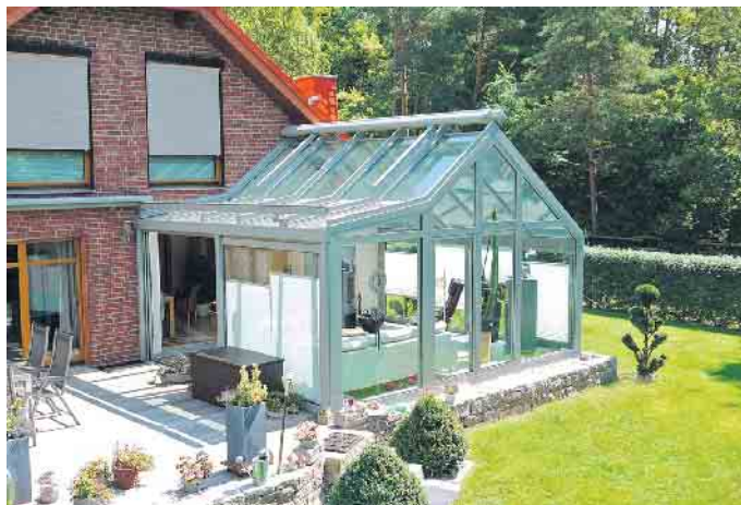
Ein Wintergarten verbindet Haus und Garten und sorgt für mehr Tageslicht im Haus. Foto: DJD/Bundesverband Wintergarten
