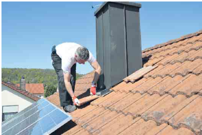
Anschlüsse an Dachdurchdringungen werden beim DachCheck begutachtet. Foto: HF Redaktion/akz—o
