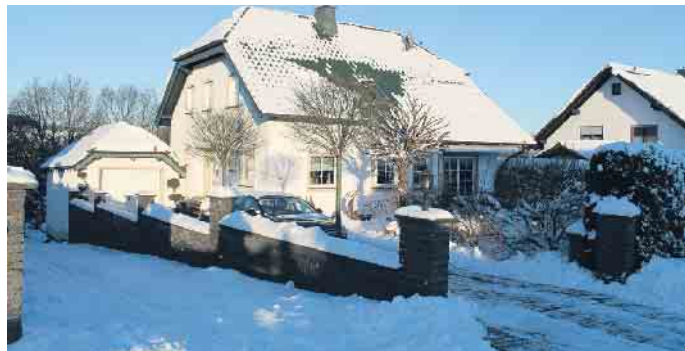
Dächer werden durch vielfältige Witterungen und Temperaturunterschiede beansprucht. Ein regelmäßiger Check sorgt für Sicherheit. Foto: ZVDH/akz-o
