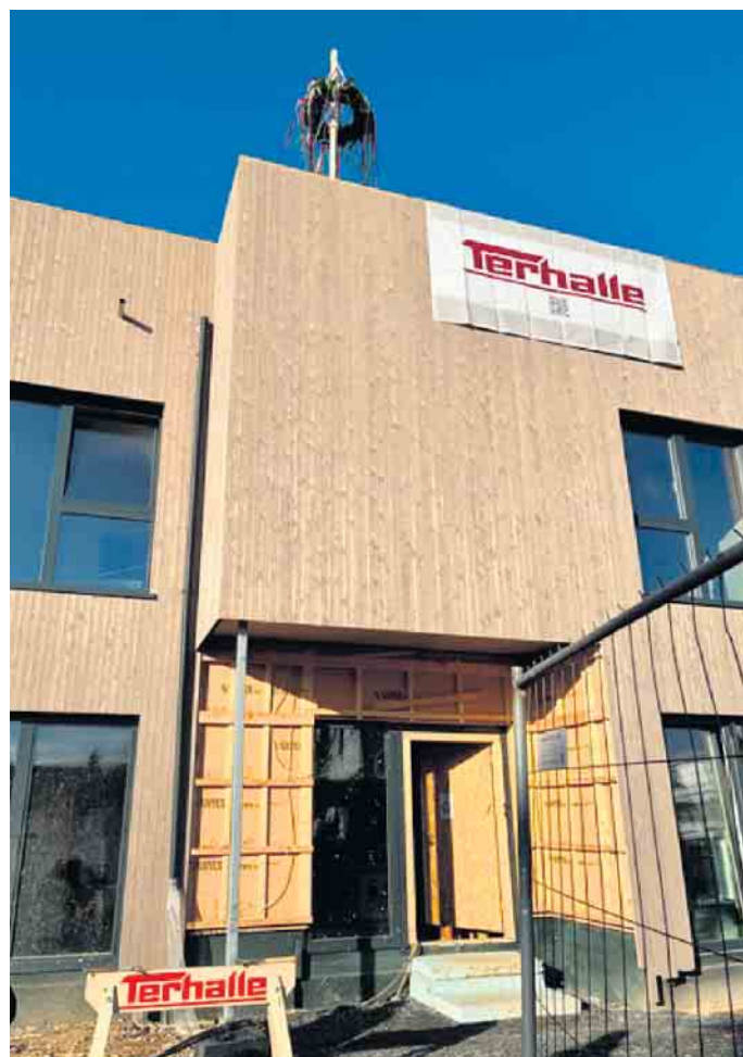
An der Wilhelm-Neuss-Straße in Lessenich-Meßdorf baut ein Totalunternehmer im Auftrag des Städtischen Gebäudemanagement eine neue Kindertagesstätte. Foto: Bundesstadt Bonn
