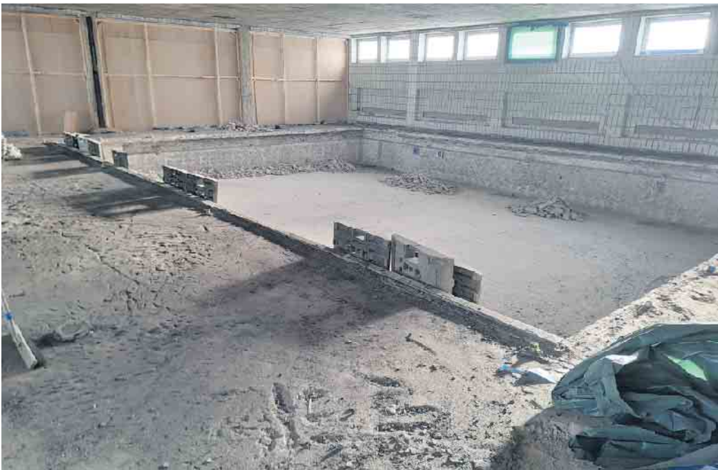
Das Lehrschwimmbecken ist nach der Schadstoffsanierung bis auf den Beton zurückgebaut. Foto: Bundesstadt Bonn
