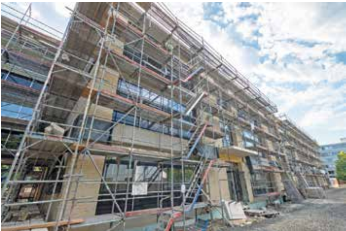
Am Friedrich-Ebert-Gymnasium entstehen unter anderem ein Erweiterungsneubau mit 19 Klassenräumen sowie eine Mensa mit Foyer.
