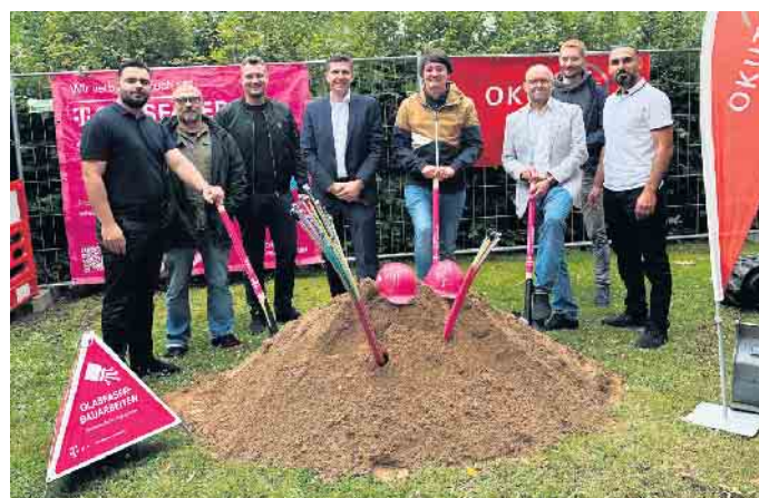
Vertreter der Telekom und der Tiefbaufirma Okutan begrüßten Bürgermeister Mario Dahm (5. v. l.), Wolfgang Rossenbach Leiter der Abteilung Digitalisierung sowie Maximilian Pfeifer Fachbereich Digitalisierung zum Spatenstich.
