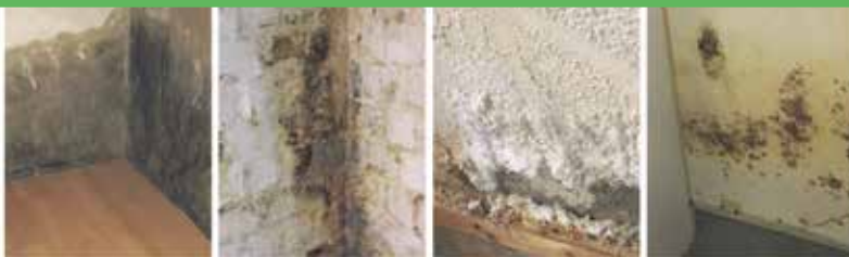
Defekte Horizontalsperre
