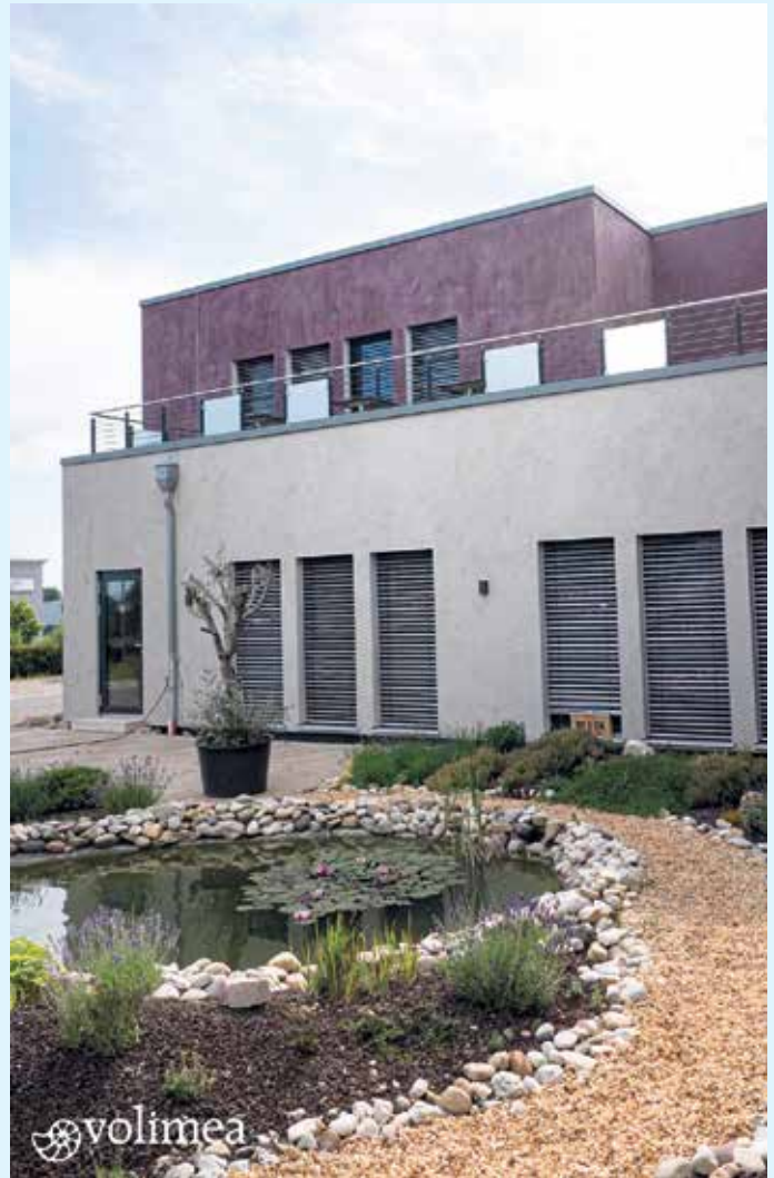
Wandbeschichtung Fassade Firmengebäude mit Fassadenfarbe von Volimea
