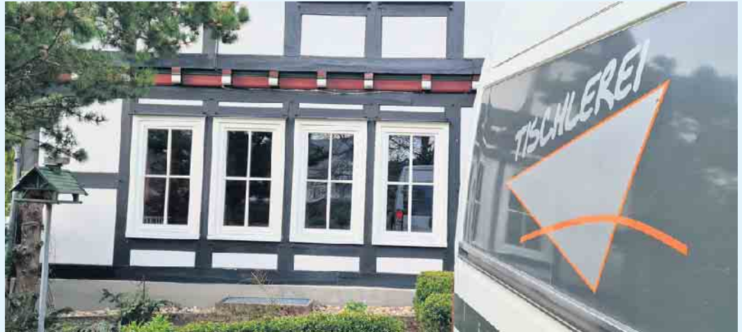
Fenstermontage von der Tischlerei Holztec
