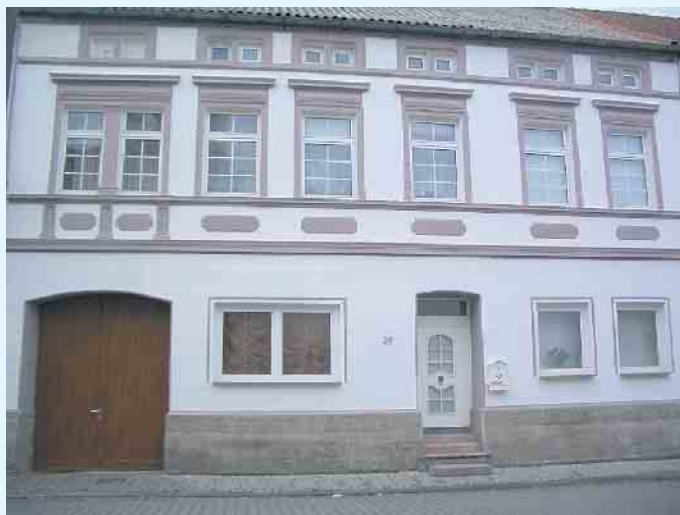
Tor- und Außentürerneuerung
