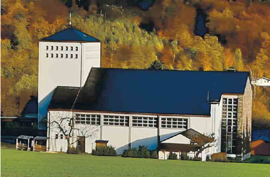
Das neue Dach von der Westansicht
