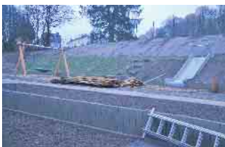
An den Außenanlagen wird noch gearbeitet
