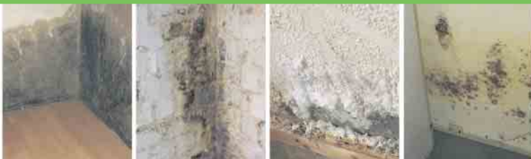
Defekte Horizontalsperre
