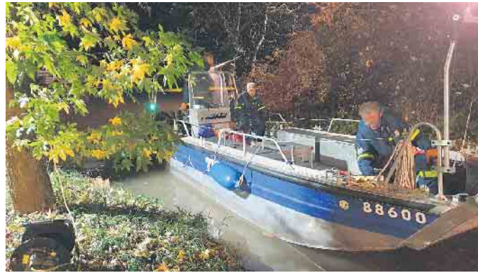
Auch das Mehrzweckarbeitsboot kam zum Einsatz (Foto: OBHF)
