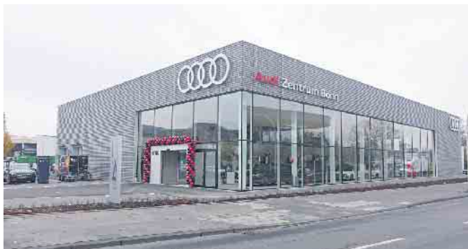
Straßenansicht des neuen AUDI Zentrums an der Bornheimer Str. 222 in Bonn
