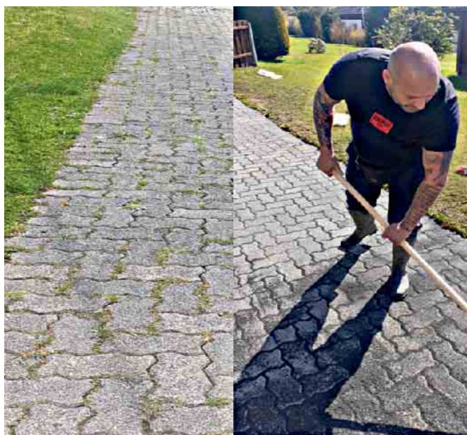
Reinigung von Fugen vorher und nachher.
