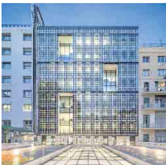
Gut für Klimabilanz und Energieausbeute: Eine vorgehängte BIPV-Lösung an der Fassade einer Gewerbeimmobilie. Copyright: AGC Glass Europe
