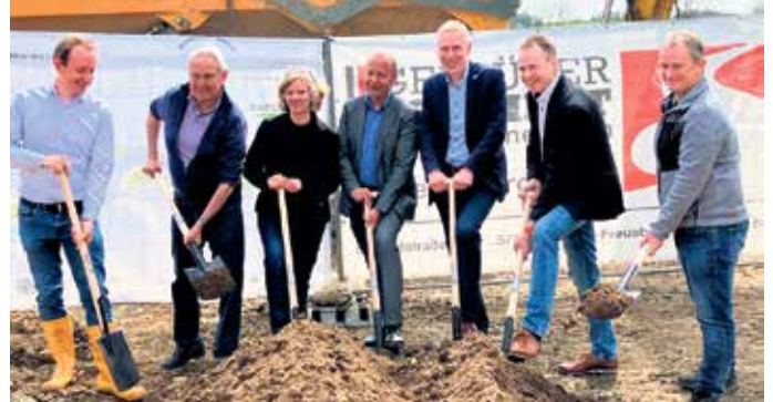
Beim Spatenstich zur Renaturierung der Agger in Lohmar-Peisel betont Bürgermeister Matthias Schmitz (Mitte) die wertvolle ökologische Bedeutung und den wichtigen Hochwasserschutz für die Stadt. (Aggerverband)
