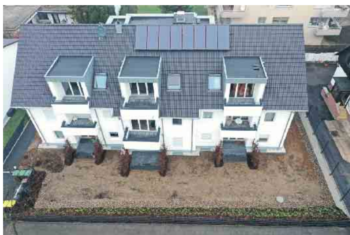
Das Dachdeckerhandwerk, der richtige Ansprechpartner für die Solaranlage auf dem Dach. Foto: ZVDH/akz-o
