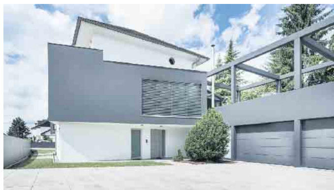
Die Fassade hat nicht nur eine schützende Funktion - sie bildet gleichzeitig das Gesicht des Eigenheims. Foto: djd/Sto/Martin Baitinger
