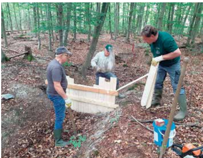
Staustufe im Aufbau
