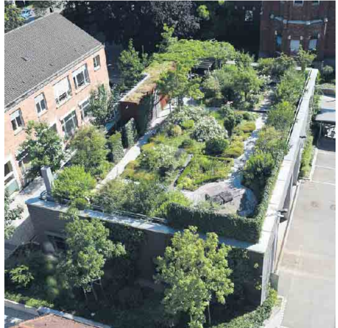
Auch Gärten sind auf Dächern möglich, es wird dann von einer intensiven Dachbegrünung gesprochen. Foto: Bundesverband GebäudeGrün e.V./akz-o
