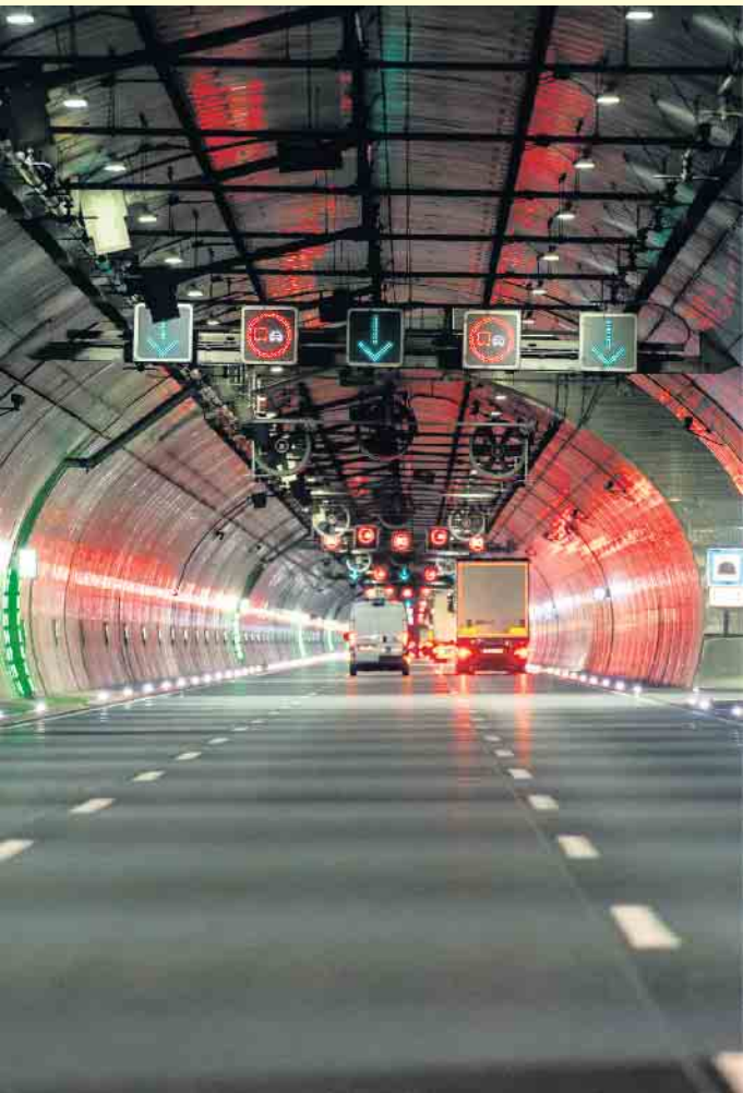
In Tunneln gibt es viele hoch entwickelte Sicherheitseinrichtungen: Videoüberwachung und Notrufstationen mit Verbindung zur Tunnelleitzentrale sind im Notfall entscheidend und sorgen für maximale Verkehrssicherheit. Foto: DJD/Fernstraßen-Bundesamt
