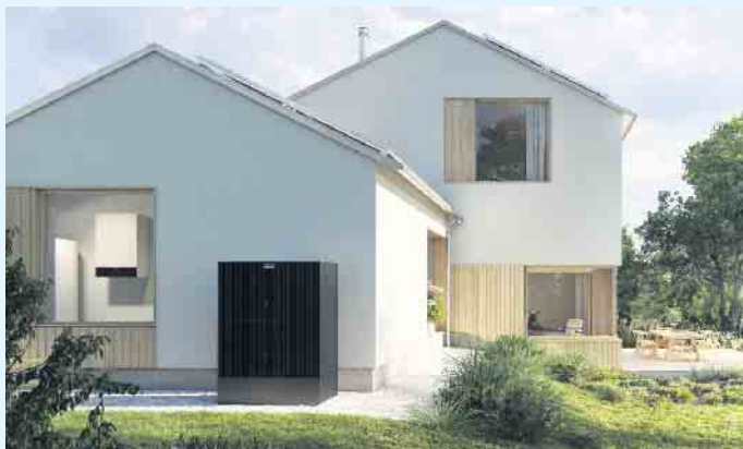
Modernes Einfamilienhaus mit PV-Anlage, Wärmepumpe und Wallbox
