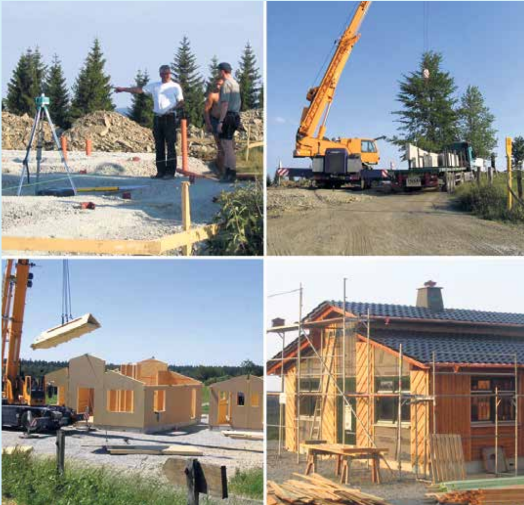
Die Hoheleyer Hütte in der Bauphase
