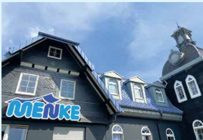
Der Meisterbetrieb Menke in Winterberg-Siedlinghausen
