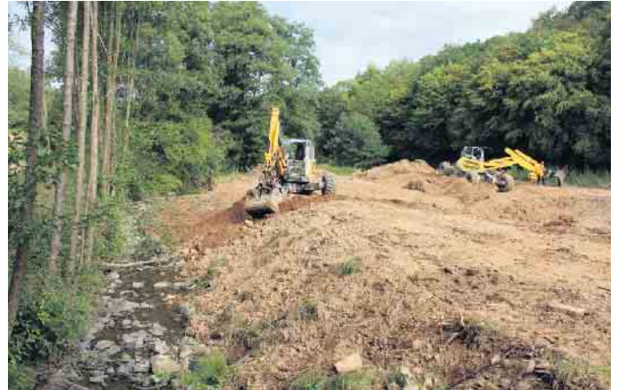
Die laufenden Gewässerrenaturierung im Krabachtal (Hennef).
