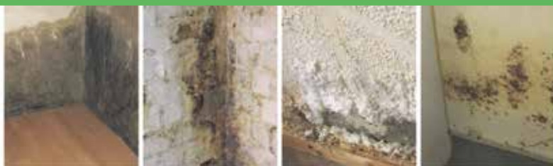
Defekte Horizontalsperre
