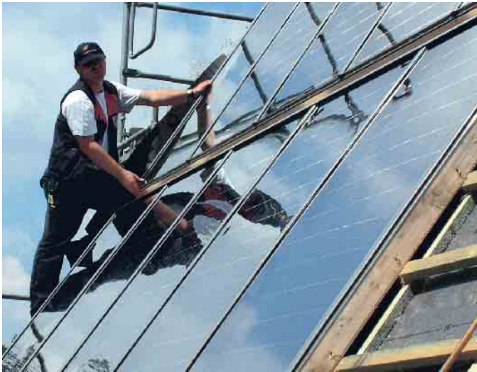
Photovoltaik: Dachdecker wissen, was zu tun ist. Foto: HF. Redaktion Harald Friedrich/akz-o
