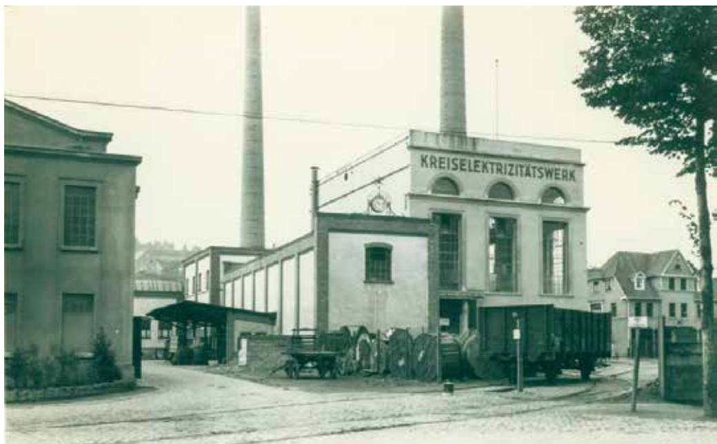
Kreiselektrizitätswerk Dieringhausen Mitte der 1920er-Jahre
