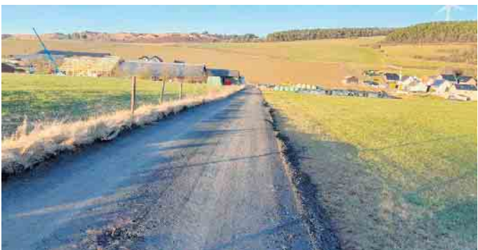
Ausschließlich für den Schulbus, die Feuerwehr sowie für Rettungs- und Räumdienst wurde im Vorfeld der Sperrung dieser Wirtschaftsweg ertüchtigt. Foto: Stadt Mechernich/pp/Agentur ProfiPress
