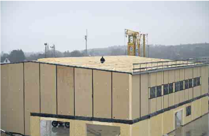
Bis Mitte März hoffen die beteiligten Firmen, mit dem Dach der Turnhalle fertig zu sein, um Fenster einbauen zu können.
