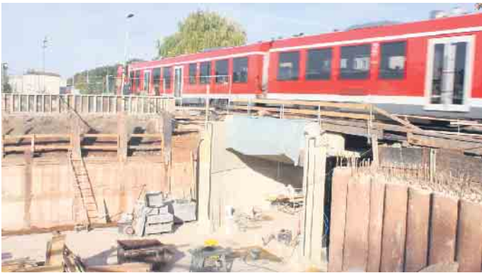
Wie eine „Operation am offenen Herzen“ verliefen die umfangreichen Bauarbeiten an der Bahnstrecke Köln-Trier-Saarbrücken durch die Ortslage von Mechernich, hier passiert ein Nahverkehrszug die Baustelle an der Bahnunterführung Friedrich-Wilhelm-StraÙe. Foto: Steffi Tucholke/pp/Agentur ProfiPress
