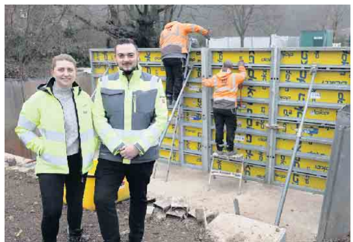
Irma Schmidt und Marvin Pärschke vor den Spundwänden, die nach den Betonierarbeiten von Mitarbeitern der Firma Backes wieder abgebaut werden konnten. Foto: Steffi Tucholke/pp/Agentur ProfiPress
