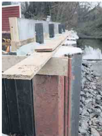
Um die Widerlager der Brücke zu fertigen, wurde mit Spundwänden eine Schalung erstellt, in die der Beton gegossen wurde. Ist dieser ausgehärtet, können die Brückenplatten auf die Widerlager aufgelegt werden. Foto: Steffi Tucholke/pp/Agentur ProfiPres
