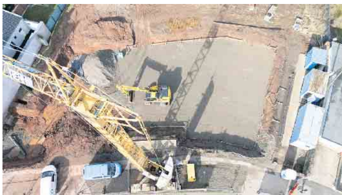
Derzeit sind die Bauarbeiten in vollem Gange. Luftbild: Henri Grüger/pp/Agentur ProfiPress
