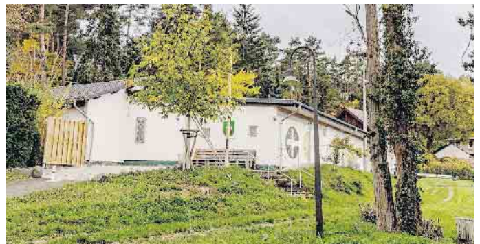
In Schießsportkreisen wurde das Kommerner Schützenhaus spöttisch „die ewige Baustelle“ genannt, damit ist jetzt Schluss. Im Mai 2023 kommen Sanierung, Dämmung, Modernisierung und der geräuscharme Umbau der Schießstände zum Abschluss, für die die Sankt-Sebastianus-Schützenbruderschaft Kommern 1859 e.V. in den vergangenen beiden Jahren rund 300.000 Euro aufgewendet hat.
