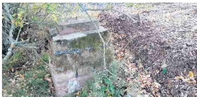
Erich Hermes aus Bergbuir fotografierte den Sockel, von dem das Gedenkkreuz vermutlich bei Baumfällarbeiten heruntergestoßen worden war. Es wurde unter Erde und Spänen rechts verscharrt und von Hermes wieder ausgegraben.
