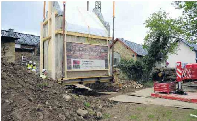
Ein Gebäude mit Geschichte. Wir schreiben sie weiter. Mit diesem Slogan der beauftragten Spezialfirma machte sich das Trafohäuschen auf die Reise.
