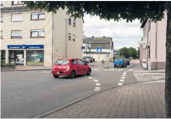
Verkehrsteilnehmer werden gebeten, die Baustelle großräumig zu umfahren, weil es sonst schnell zu verstärktem Rückstau in die Kreisverkehre, hier Turmhofstraße/Rathergasse, kommen kann.
