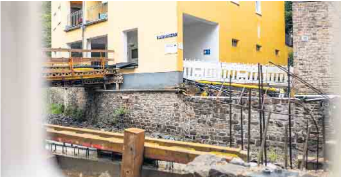
Blick durch eine Baustellen-Bake: Die Widerlager stehen, die neue Brücke in der Werther Straße nimmt Gestalt an und damit werden auch die elf Wohnungen für Seniorinnen und Senioren des Vereins Haus Sonne wieder besser erschlossen. Foto: Ronald Larmann/pp/Agentur ProfiPress
