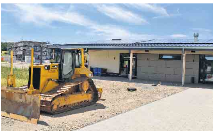
Mitten im neuen Siedlungsschwerpunkt wird derzeit noch gearbeitet. Foto: Cedric Arndt/pp/Agentur ProfiPress
