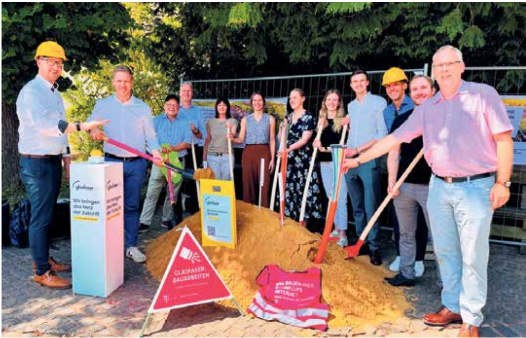
Symbolischer Spatenstich: In Schleiden-Wolgarten startete das 61-Millionen-Euro-Projekt zum geförderten Glasfaserausbau. Im zweiten Ausbaucuster sollen 4.516 Adressen im Stadtgebiet Mechernich mit leistungsfähigen Glasfaseranschlüssen erschlossen werden. Foto: W. Andres/Kreis Euskirchen/pp/Agentur ProfiPress
