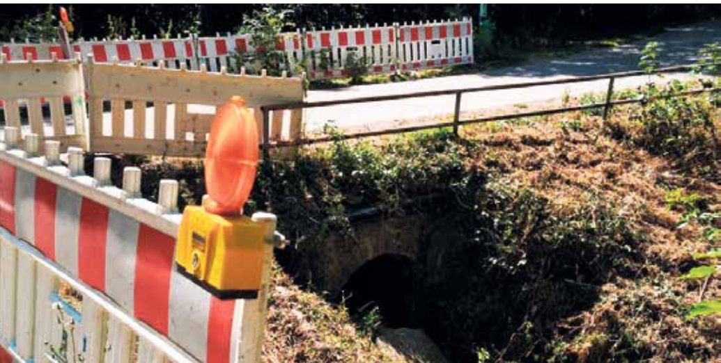
In Eicks wird ab Montag, 3. August, der beschädigte Mauerwerksdurchlass am Mehlenbach ersetzt. Die neue Konstruktion wird dann auch für Schwerlastverkehr ausgelegt sein. Foto: Kerstin Rottland/ pp/Agentur ProfiPress
