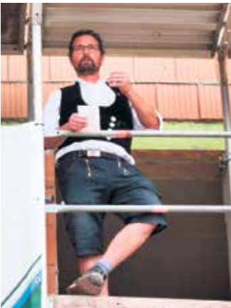
Zimmerer René Bruns aus Vussem sprach vom Gerüst vor dem neu erbauten Mehrfamilienhaus den Richtspruch. In den Wohnungen könnten bald Mitarbeiter mit ihren Familien leben. Foto: Kerstin Rottland/pp/Agentur ProfiPress
