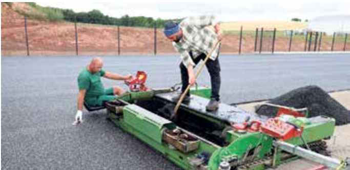
Mitarbeiter der Firma Cordel-Bau, einer Fachfirma für Sportplatzbau aus Wallenborn im Landkreis Vulkaneifel, tragen die elastische Tragschicht Bahn für Bahn mit speziellen Geräten auf. Foto: Steffi Tucholke/pp/Agentur ProfiPress
