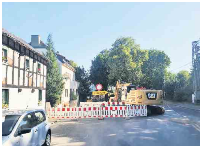
Die zurzeit laufende Bachverrohrung Schützendorf in neue größere 80er Rohre soll in rund vier Wochen beendet sein, sagte der städtische Ingenieur Jörg Nußbaum dem „Bürgerbrief“. Der Mühlenbach, der auch den örtlichen Löschteich („Pool“) speist, war bislang in 60er Rohren verlegt. Die größere Dimensionierung soll dem Hochwasserschutz dienen. Foto: Manfred Lang/pp/Agentur ProfiPress
