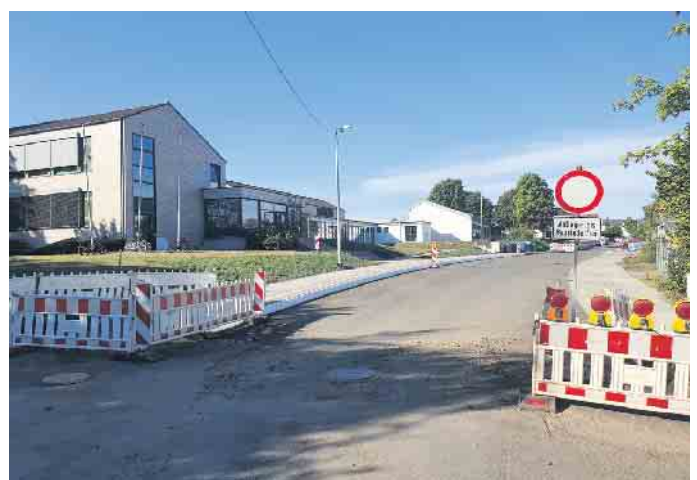
Die neue Bushaltestelle vor der Grundschule Lückerrath mit Radfahrer- und Rollstuhlfahrerrampe ist schon weit gediehen. Dennoch soll die Sperrung noch bis nächstes Jahr aufrechterhalten werden. Foto: Manfred Lang/pp/Agentur ProfiPress
