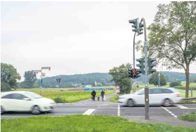
Die Baumaterialien liegen in der Ferne bereit. Der Abzweig vom Mechernicher Weg zum Sportplatz ist seit Anfang September voll gesperrt, weil die Straße für die künftige Feuerwache ausgebaut wird. Foto: Ronald Larmann/pp/Agentur ProfiPress
