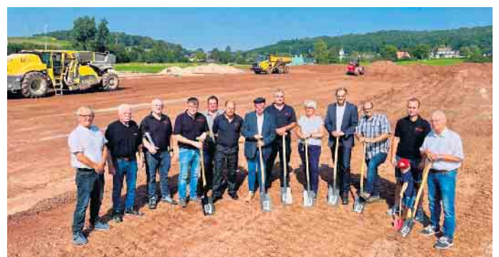
Der Boden ist bereit: Den Spatenstich für das neue Feuerwehrgerätehaus Kommern vollzog Bürgermeister Dr. Hans-Peter Schick (r.) mit Vertretern von Verwaltung, Politik, Feuerwehr, Baufirma und Architekturbüro. Foto: R. Larmann/pp/Agentur ProfiPress
