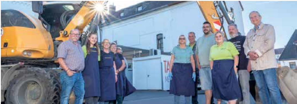
Sonniger Baustart: Der Vorsitzende Wolfgang Weilerswist (l.) und das Team der Tafel Mechernich freuen sich über den Beginn der Erweiterungsarbeiten auf dem Hof der ehemaligen Barbaraschule. Foto: Ronald Larmann/pp/Agentur ProfiPress
