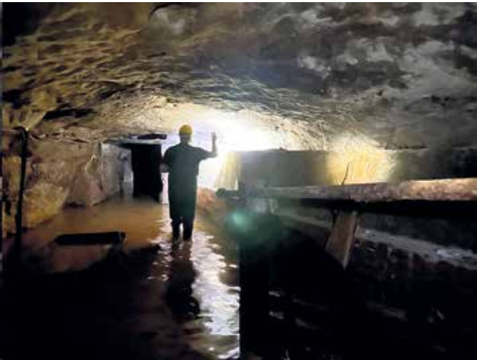
Im Burgfeyer Stollen steht das Wasser stellenweise hoch. Der historische Wasserlösungsstollen führt große Wassermengen aus dem alten Mechnicher Bleibergbau ab und bleibt für den Wasserhaushalt unter Tage von zentraler Bedeutung. 1,2 Millionen Liter Wasser pro Stunde fließen unter der Mechnicher Kernstadt durch Richtung Burgfeyer Mündungsloch in den Feybach. Foto: Kreis Euskirchen/pp/Agentur ProfiPress
