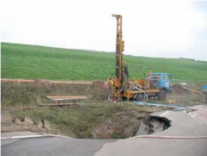
Der alte Bleibergbau prägt den Untergrund bis heute. Tagesbrüche wie dieser zeigen, warum Standsicherheit, Verfüllung alter Hohlräume und dauerhafte Kontrolle am Standort Virginia auch in Zukunft wichtige Themen bleiben. Foto: Kreis Euskirchen/pp/Agentur ProfiPress
