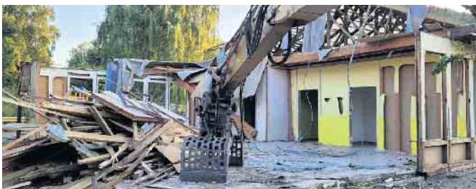
Vor gut acht Monaten musste der alte Gebäudetrakt abgerissen werden
