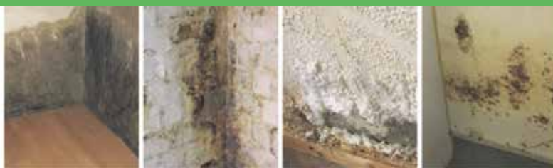
Defekte Horizontalsperre
