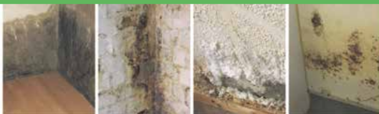
Defekte Horizontalsperre
