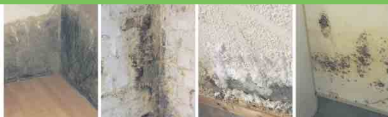
Defekte Horizontalsperre
