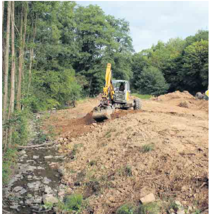
Laufenden Gewässerrenaturierung im Krabachtal (Hennef). Fotos. Rhein-Sieg-Kreis
