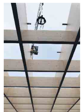
Der Richtkranz über dem zukünftigen Dach der Mensa
