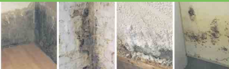
Defekte Horizontalsperre
