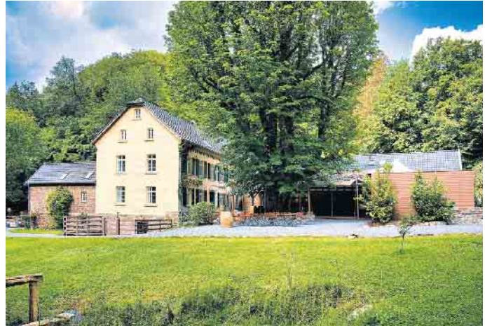
Die unter Denkmalschutz stehende Kupfersiefer Mühle bei Köln erhält eine neue Zukunft mit innovativen, kreislauffähigen Baumaterialien. Foto: djd/www.megawood.com
